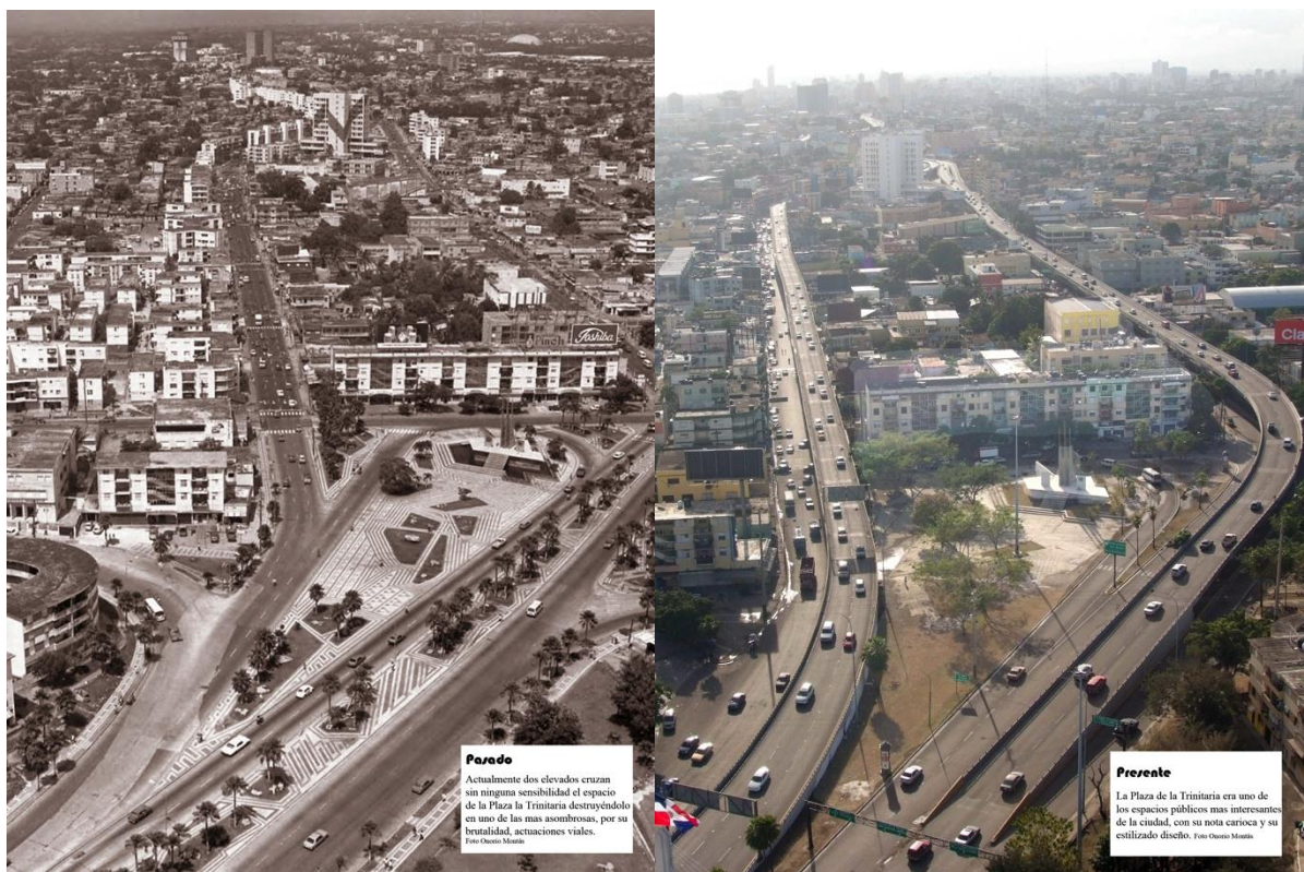
Foto 1. Plaza La Trinitaria. Benjamin Paeiwosky. Antes y después dela intervención con los elevados. Fotos tomadas de la exposición Santo Domingo: Presente Pasado. Una Visión Comparativa de la Transformación de Santo Domingo. CODIA. 2009. Fotos de Onorio Montás.
